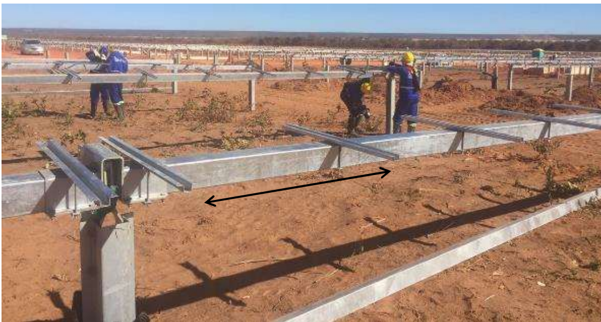
Figura 3.11 - Montagem de Vigas e Perfis de sustentação das Placas
