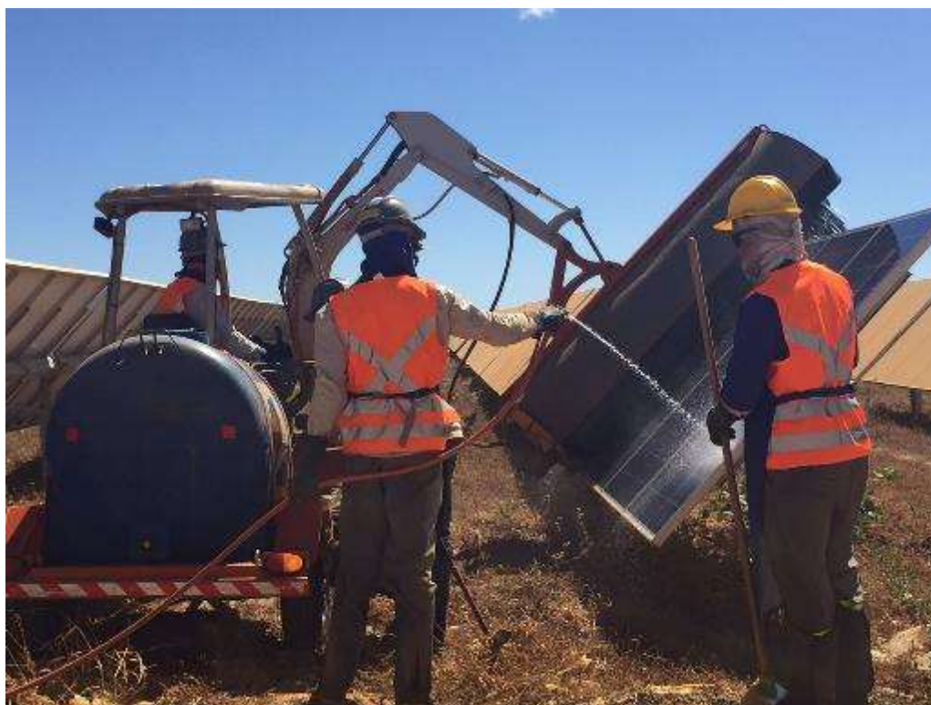
Figura 3.15 - Limpeza semi mecanizada de painéis fotovoltaicos
