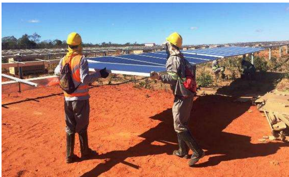
Figura 3.13 - Montagem de Painéis Fotovoltaicos
