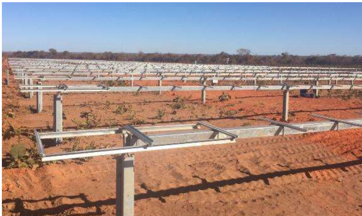
Figura 3.1 – Estrutura do Rastreador Solar
