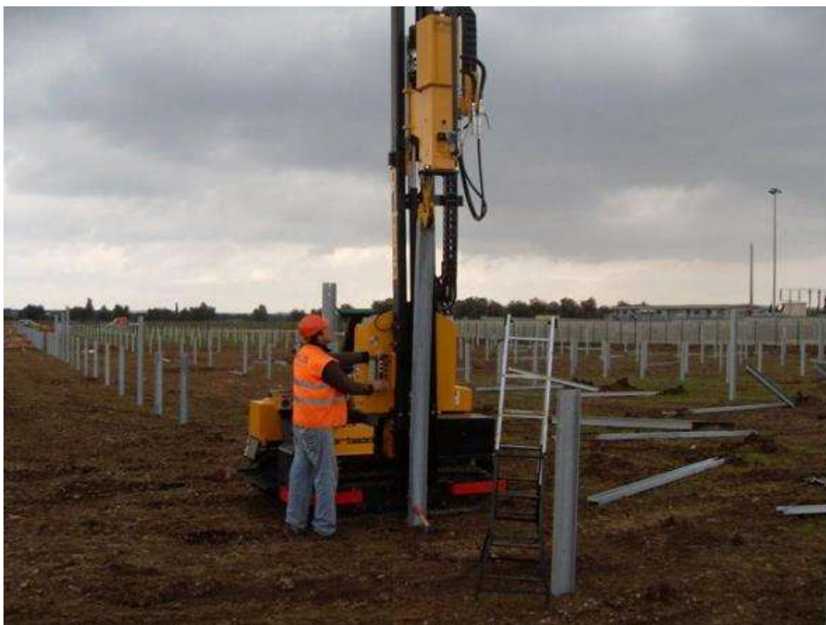
Figura 3.9 - Cravação de estacas de sustentação do rastreador solar (Orteco, 2015)
